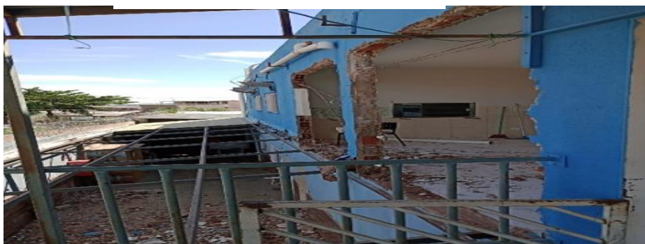
Figura 1 AMPLIAÇÃO REFEITORIO- ANTES
