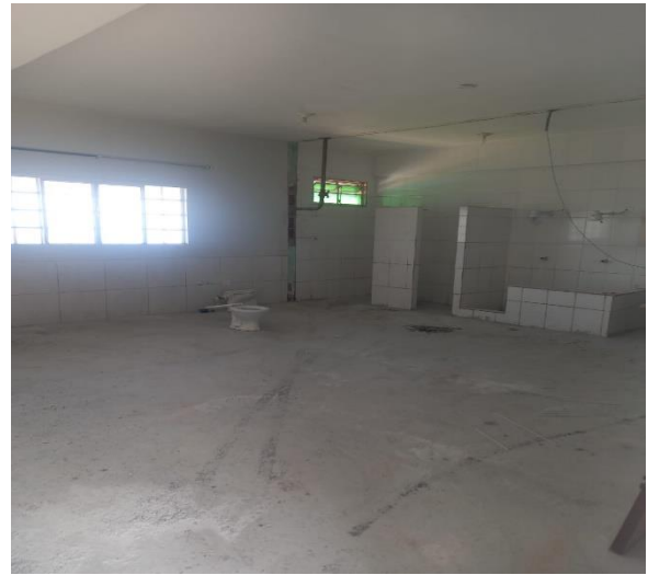
Figura 4 TROCA PISO E AMPLIAÇÃO BANHEIRO SALA1
