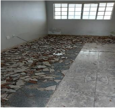
Figura 6 TROCA DO PISO -SALA AULA
