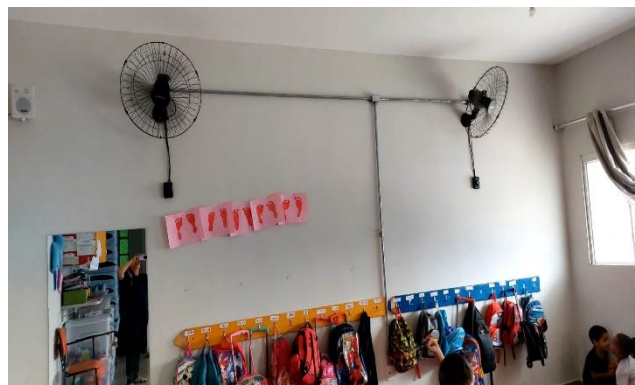
Figura 9- Instalação de Ventiladores nas salas
