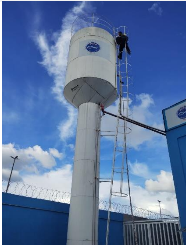
Figura 7 LIMPEZA CAIXA D'AGUA
